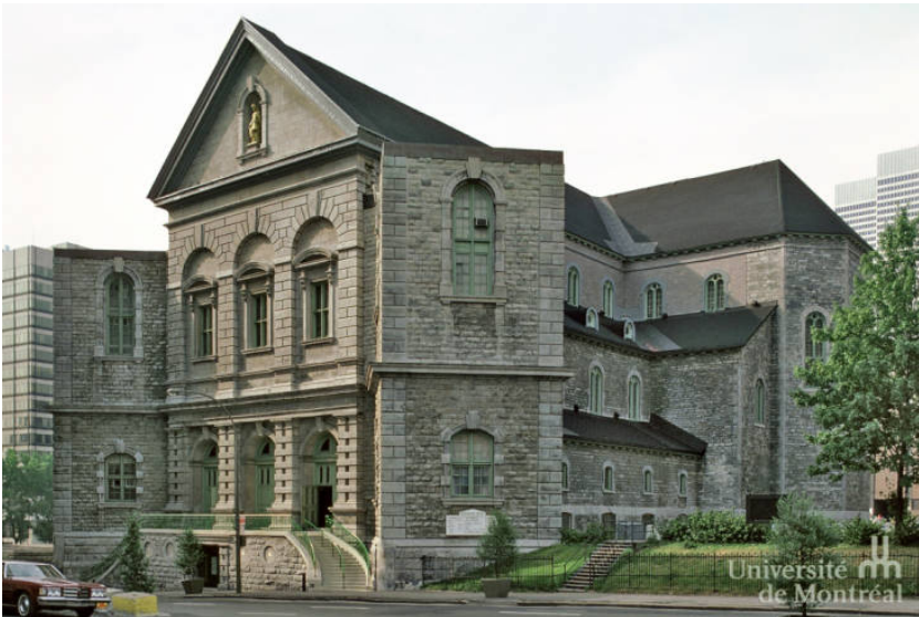
Église Le Gesù et son amphithéâtre en sous-sol. Extérieur, vue vers le sud-ouest prise à partir de la rue D e Bleury. À noter que les deux tours avant, dont les clochers, restent inachevés. Connue sous le nom de Chapelle du Gesù durant l'existence du Collège Sainte-Marie. Architecte : Patrick Charles Keeley (1864-1865). Photo : Pierre-Richard Bisson, 1979. Archives de l'Université de Montréal. Succession Pierre-Richard Bisson.
