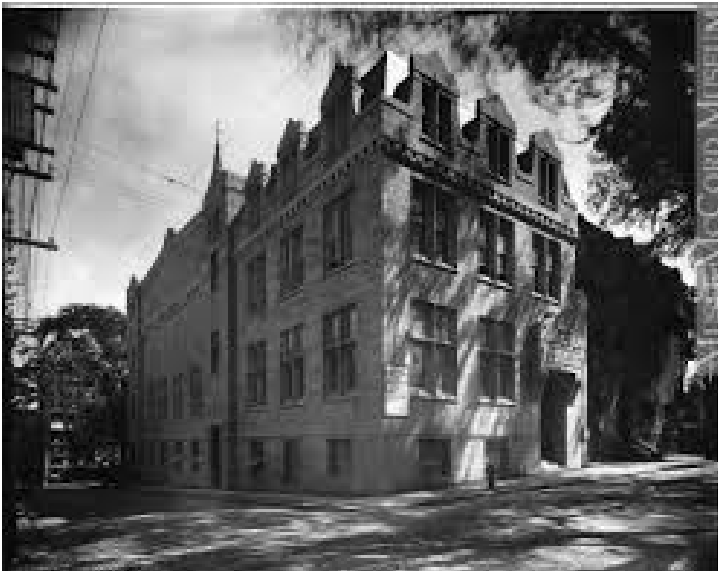
St. Patrick's Congress Hall, 454, rue Dorchester Ouest (aujourd'hui boul. René-Lévesque Ouest), construit en 1914. Photo : William Notman, 1915. Musée McCord.
