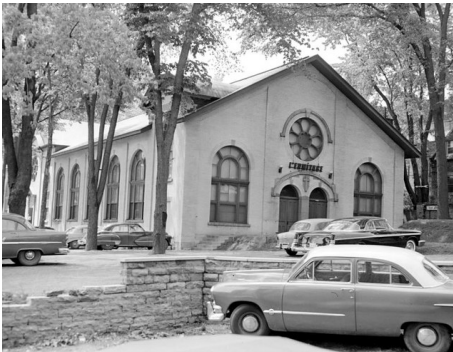
Vue de la façade latérale de l'Ermitage donnant sur le chemin Côte-des-Neiges. Architecte : Joseph-Albert-Hector Lapierre. Photo : BAnQ, 1956.
